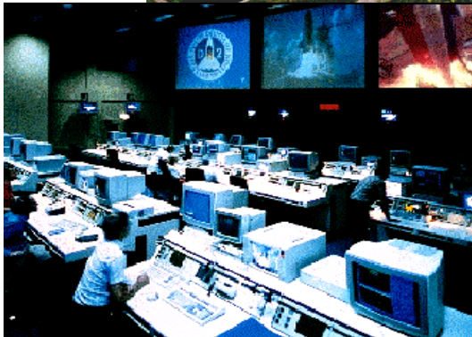
Control Center Oberpfaffenhofen
